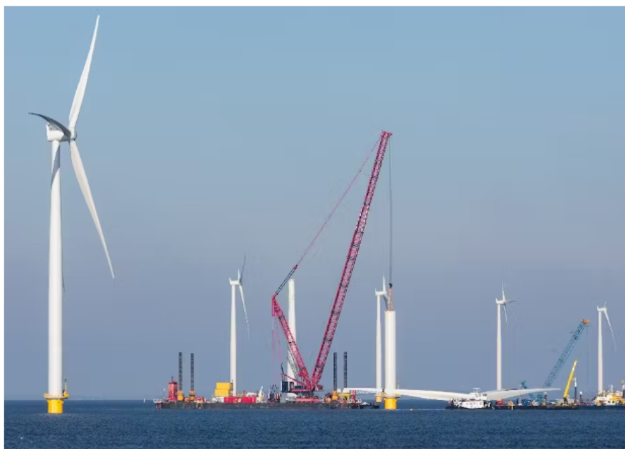
Turbinas eólicas em construção em parceria com o Senai, no litoral do Rio Grande do Norte: volume de investimentos da Petrobras em baixo carbono subiu de US$ 4,4 bilhões para US$ 11,5 bilhões entre o último quadriênio e o que se inicia agora em 2024. Divulgação / Senai. CC BY
