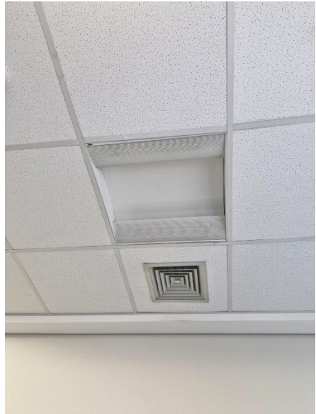
Foto 12: Lâmpadas da luminária da sala de reunião ao lado da recepção queimadas.
