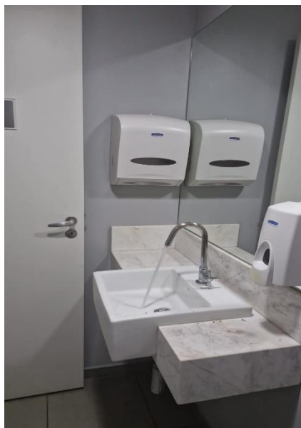
Foto 7: Sanitário do conjunto 1201.
