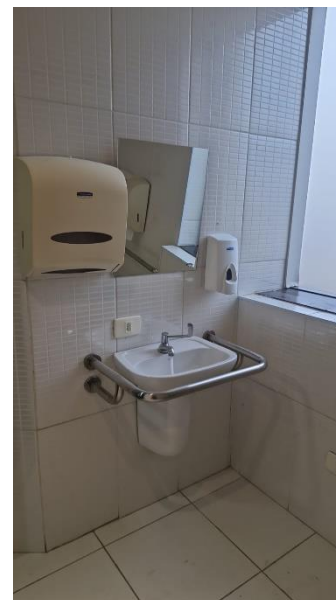
Foto 8: Sanitário PNE do conjunto 1204.
