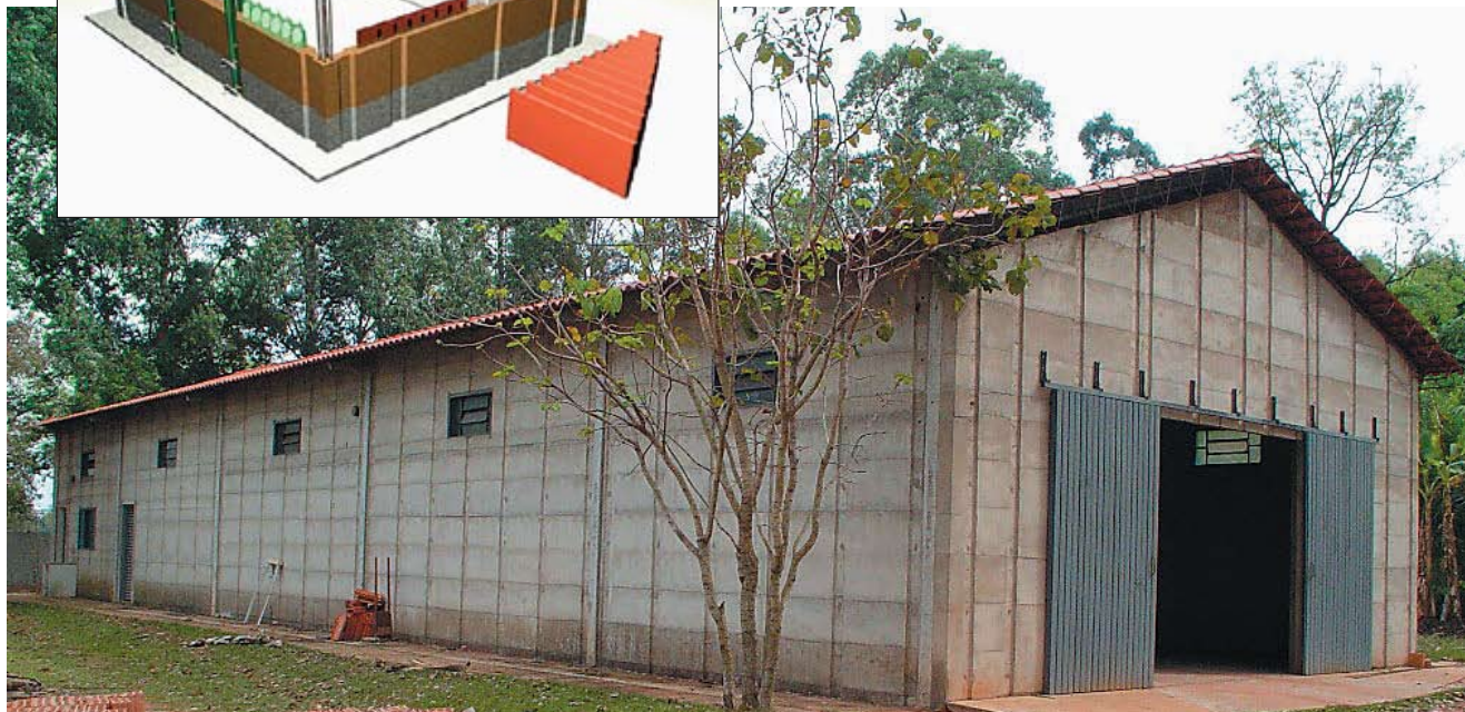
O Sistema Integrado Construtivo utiliza conjuntos de blocos feitos com materiais alternativos
