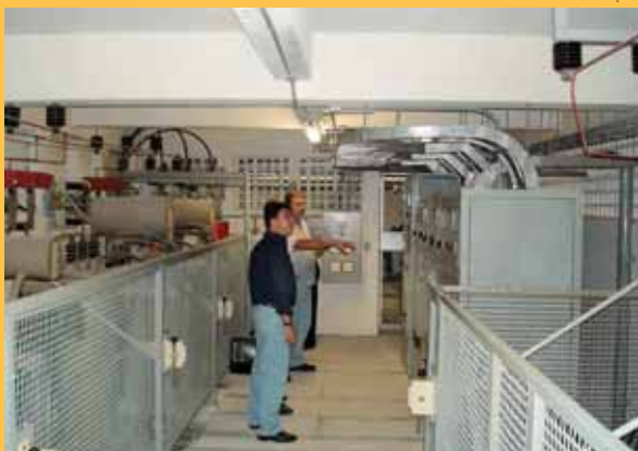
Subestação da UFRJ é recuperada com investimento da FINEP
