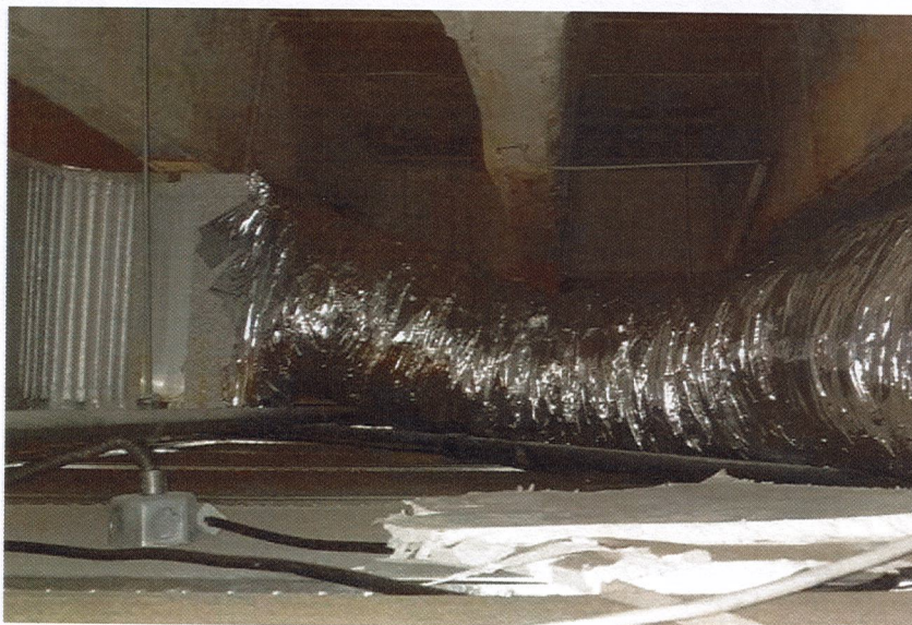
Foto 50. 16º andar | VAV 11 - Adaptação de conexões de dutos (Chapa X Flexível).
