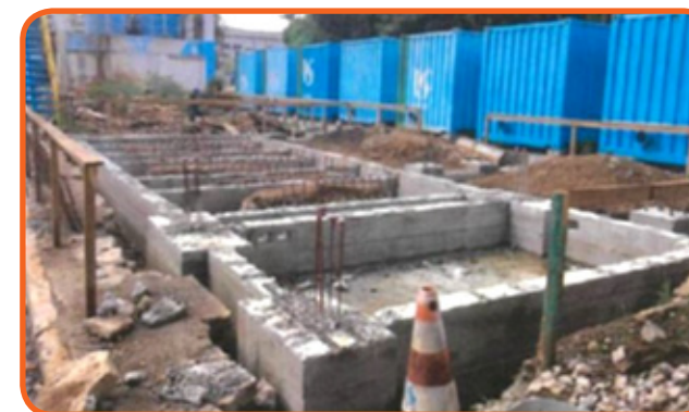
Unidades de biofiltração para controle de odores
