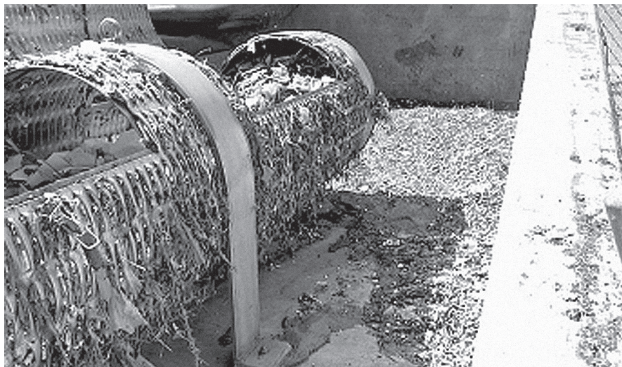
Figura 5.4 Dispositivo LR3 US-101, descoberto para remoção de sólidos.
