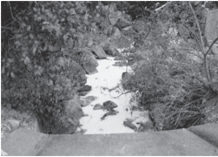
Figura 1.6 Efluente de origem doméstica na rede de drenagem.
