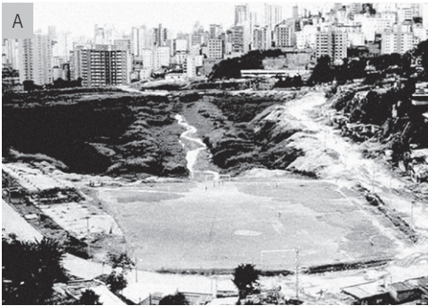
Figura 1.15 Bacia de retenção em bairro de Belo Horizonte sem melhorias.
