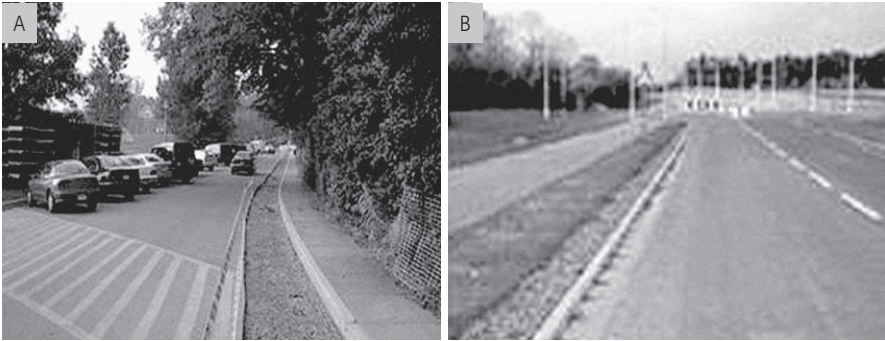
Figura 1.13 Vala de infiltração.
