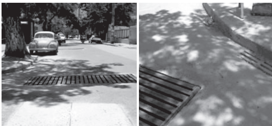
Figura 7.21 Obras concluídas. Grade por cima do reservatório e bocas-de-lobo (grelhas) na sarjeta.
