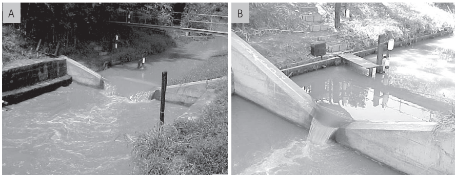
Figura 2.5 Vertedor em situação de cheia e estiagem.
