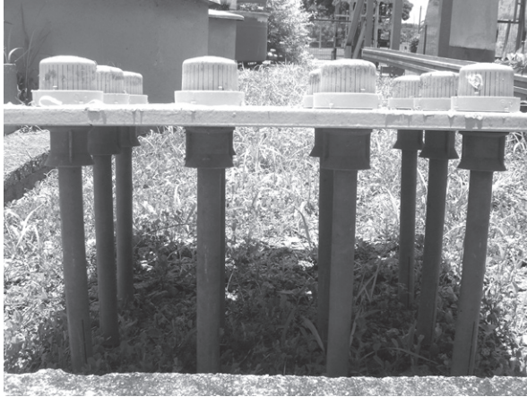
Figura 10.14 Dispositivo de coleta do efluente e de entrada de ar e água de retrolavagem
