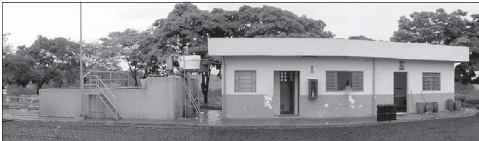
Figura 8.24 Vista geral da ETA de dupla filtração para abastecimento industrial e Casa de Química.
