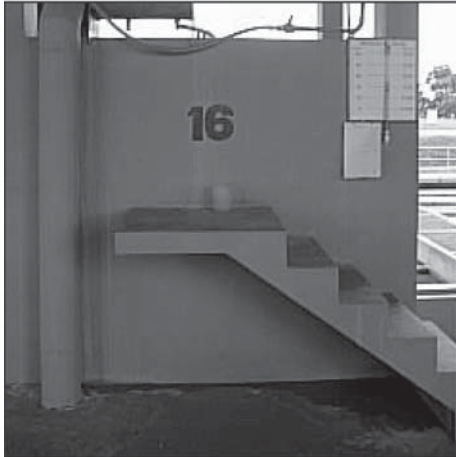
Câmaras de alimentação de cada unidade de filtração ascendente
