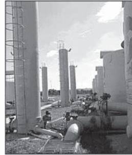
b) Câmaras individuais de alimentação dos filtros ascendentes
