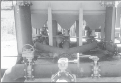
Filtro construído em chapa metálica
