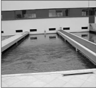
Filtro com flutuadores que acionam o sifão
