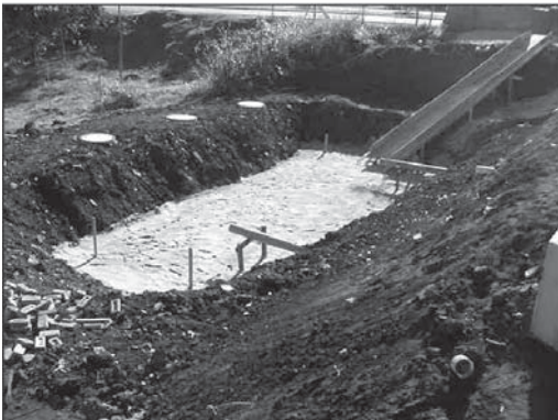
Vista geral dos leitos de secagem, tubulação de chegada do lodo e poços de drenagem
