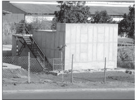
Câmaras de carga e filtros ascendentes e descendentes
