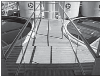
b) Câmaras individuais de alimentação dos filtros ascendentes
