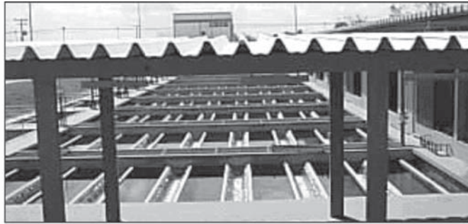
Vista geral dos filtros ascendentes
