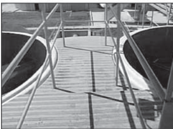
Figura 7.66 Instalação de dupla filtração com câmaras individuais de alimentação dos filtros ascendentes.
