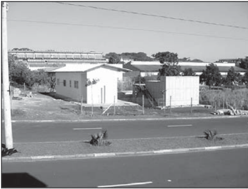
Vista geral da Casa de Química e ETA
