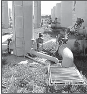
b) Câmaras individuais de alimentação dos filtros ascendentes
