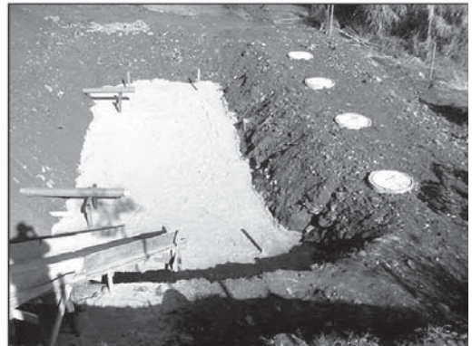
Vista geral dos leitos de secagem, tubulação de chegada do lodo e poços de drenagem
